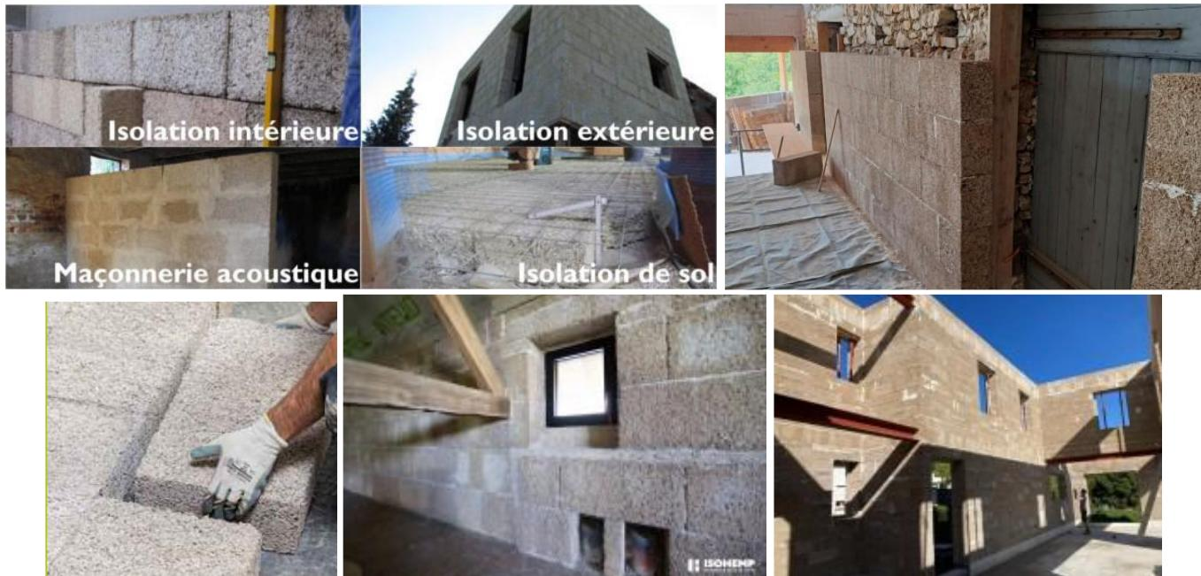
Le bloc de chanvre doit être placé à l'abri des risques d'humidité ascensionnelles. Afin de solutionner les éventuelles remontées capillaires, il convient de placer le premier lit de blocs dans un profilé PVC en U (posé à sec), ou sur une membrane étanche (bloc posé sur un mortier standard) remontant sur 20 mm le long du bloc de béton chanvre.
